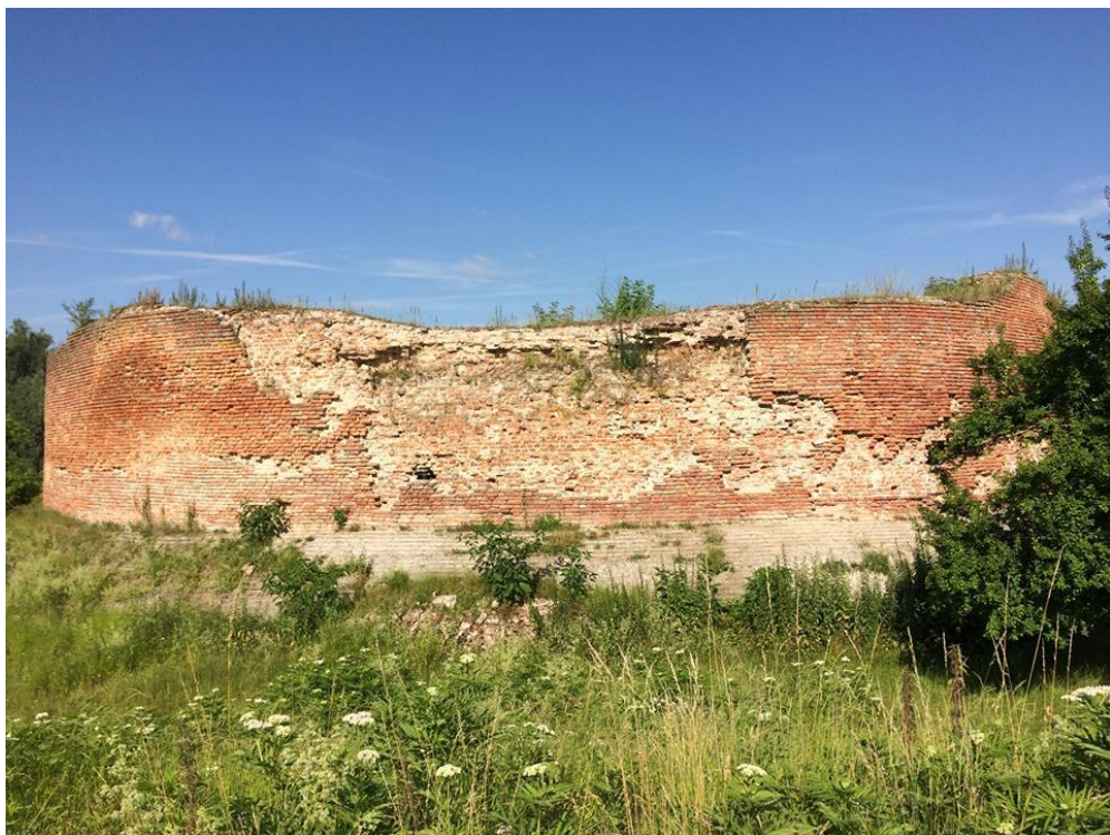
Prilog 8: Masivni i zaobljeni zidovi Korogyvara – ključno obilježje renesansne vojne arhitekture.
