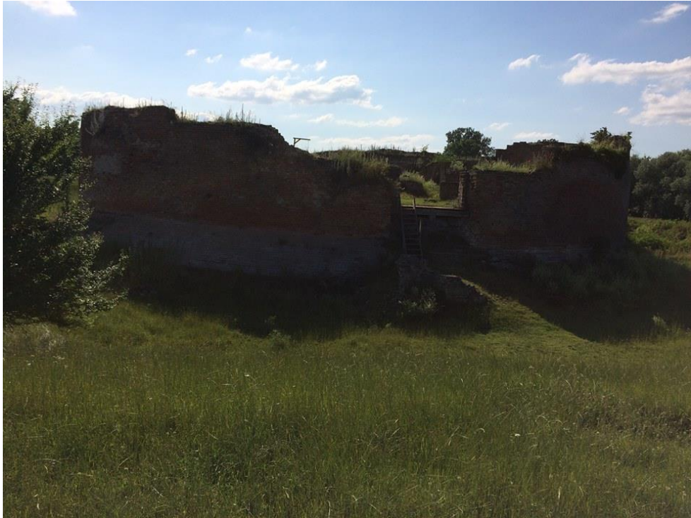
Prilog 7: Ostaci utvrde Korogyvar (Korođ) – primjer renesansne vojne arhitekture u istočnoj Slavoniji.
