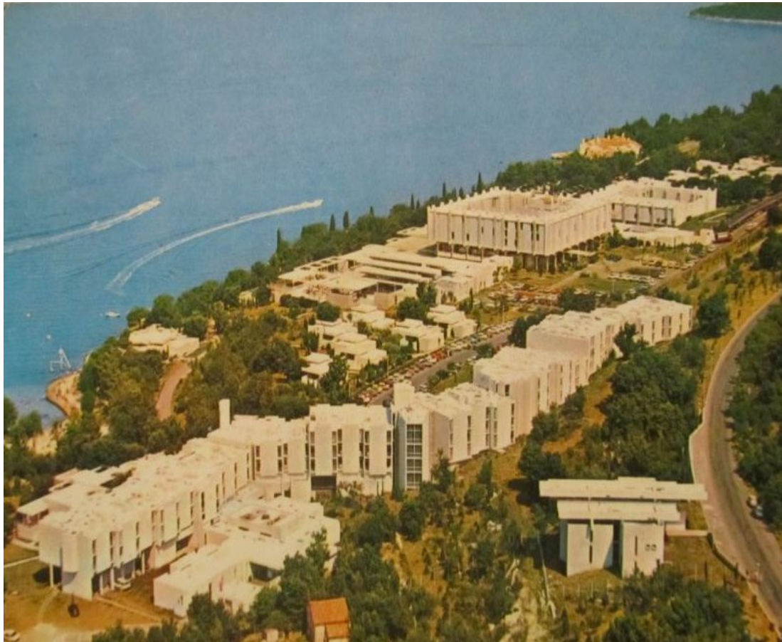
Slika 5. Komplex Haludovo na otoku Krku u Malinskoj.
