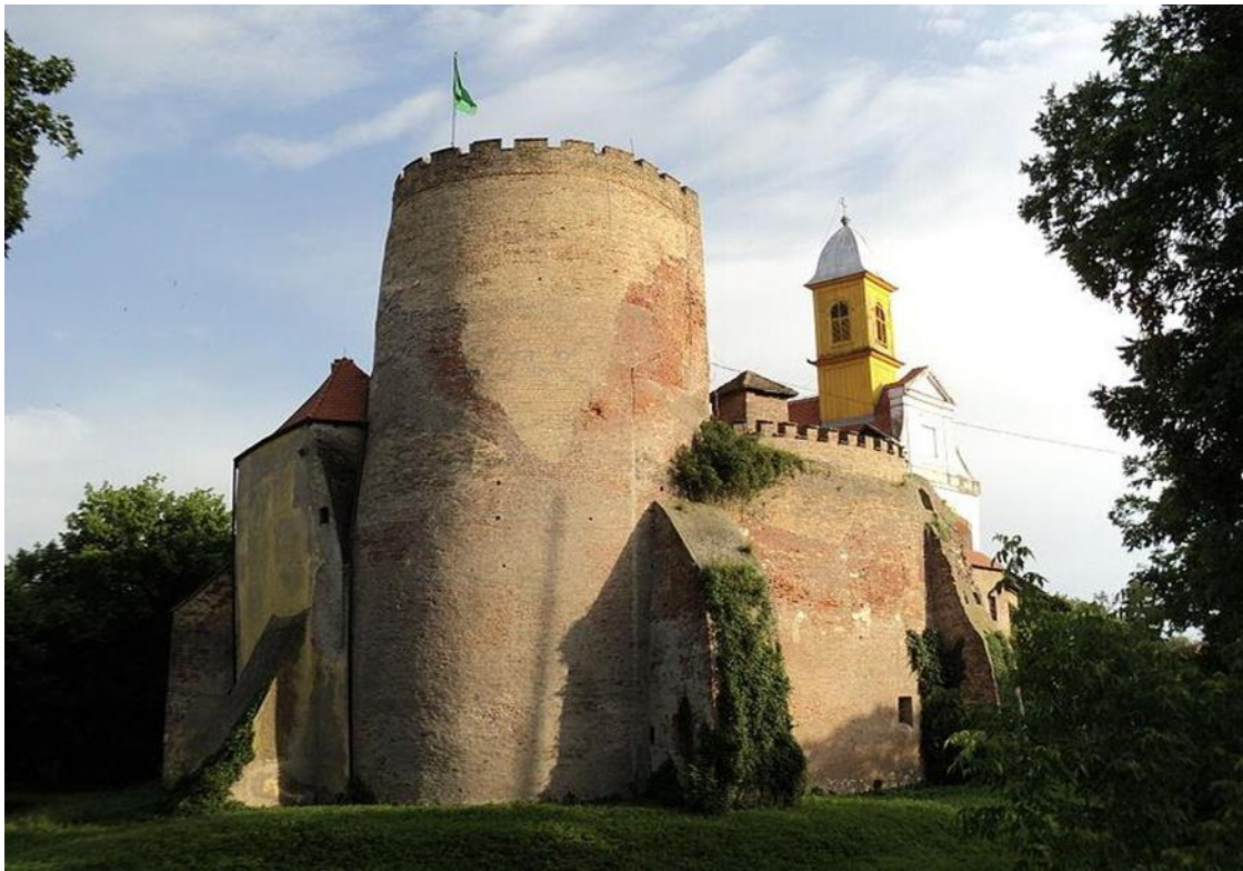
Slika 5. Ostatci tvrđave i kule Valpovo
