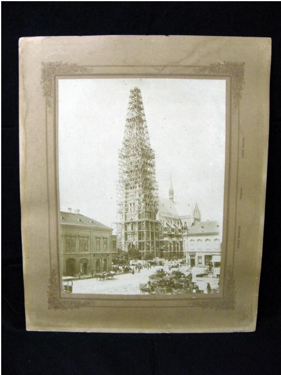
Slika 7: Fotografija izgradnje osječke katedrale
