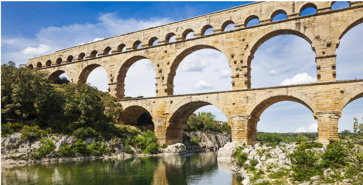
Slika 4. Akvedukt Pont du Gard, Provansa, Francuska
