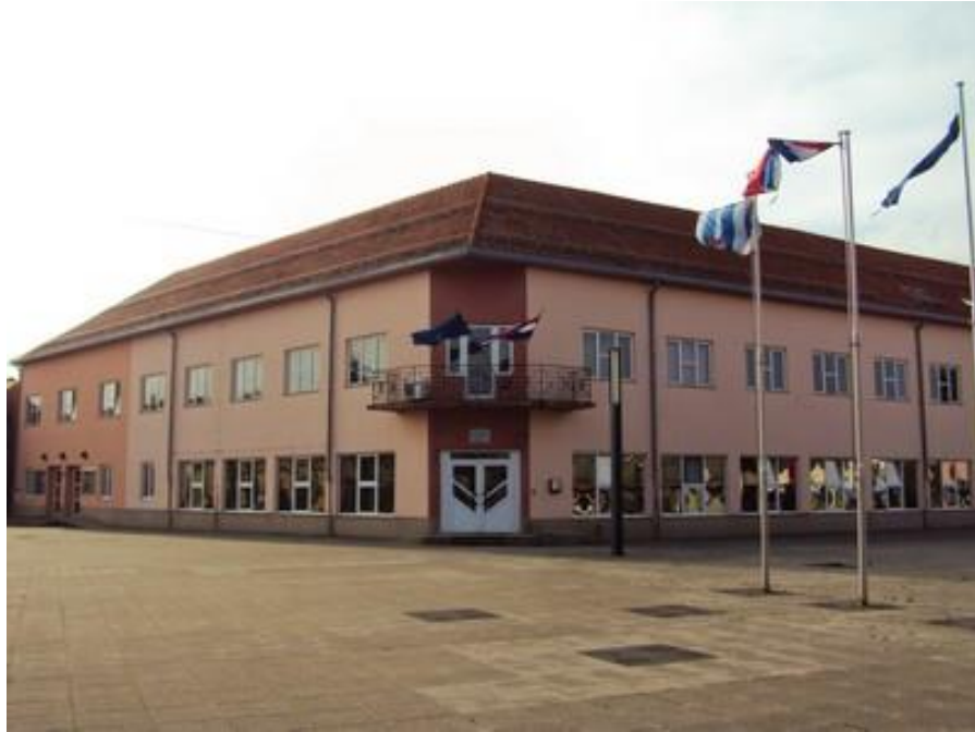
Slika 1. Zgrada Gradske knjižnice Beli Manastir
