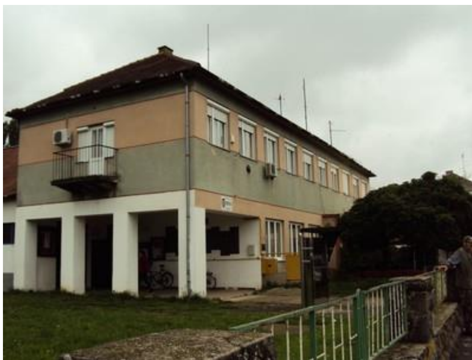
Slika 10. Zgrada Centra za kulturu Čepin – Knjižnica
