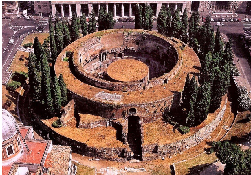
Slika 16: Pogled iz zraka na Mauzolej
