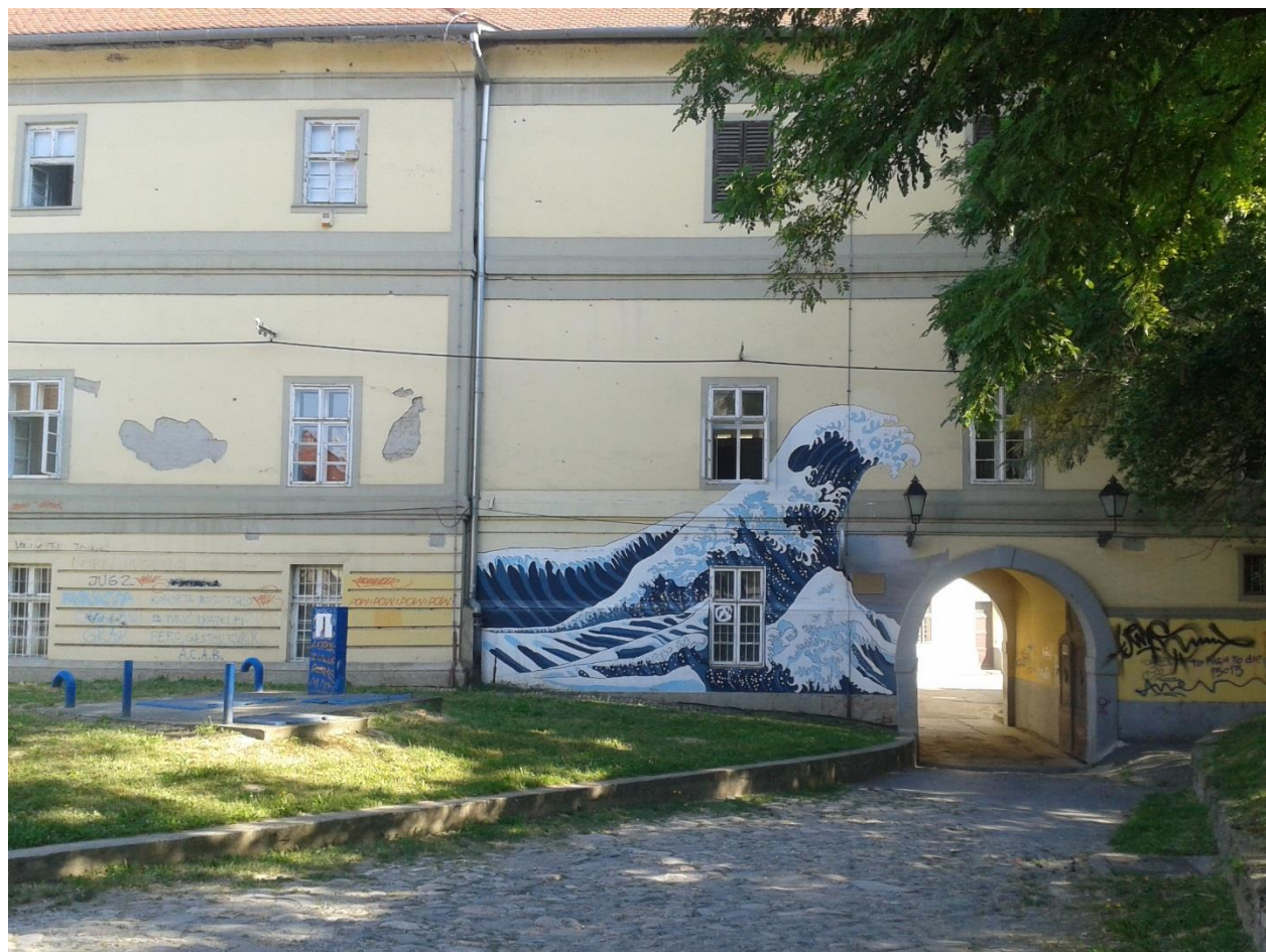
Fotografija 1. Ulaz u dvorište škole/ zgrada škole
