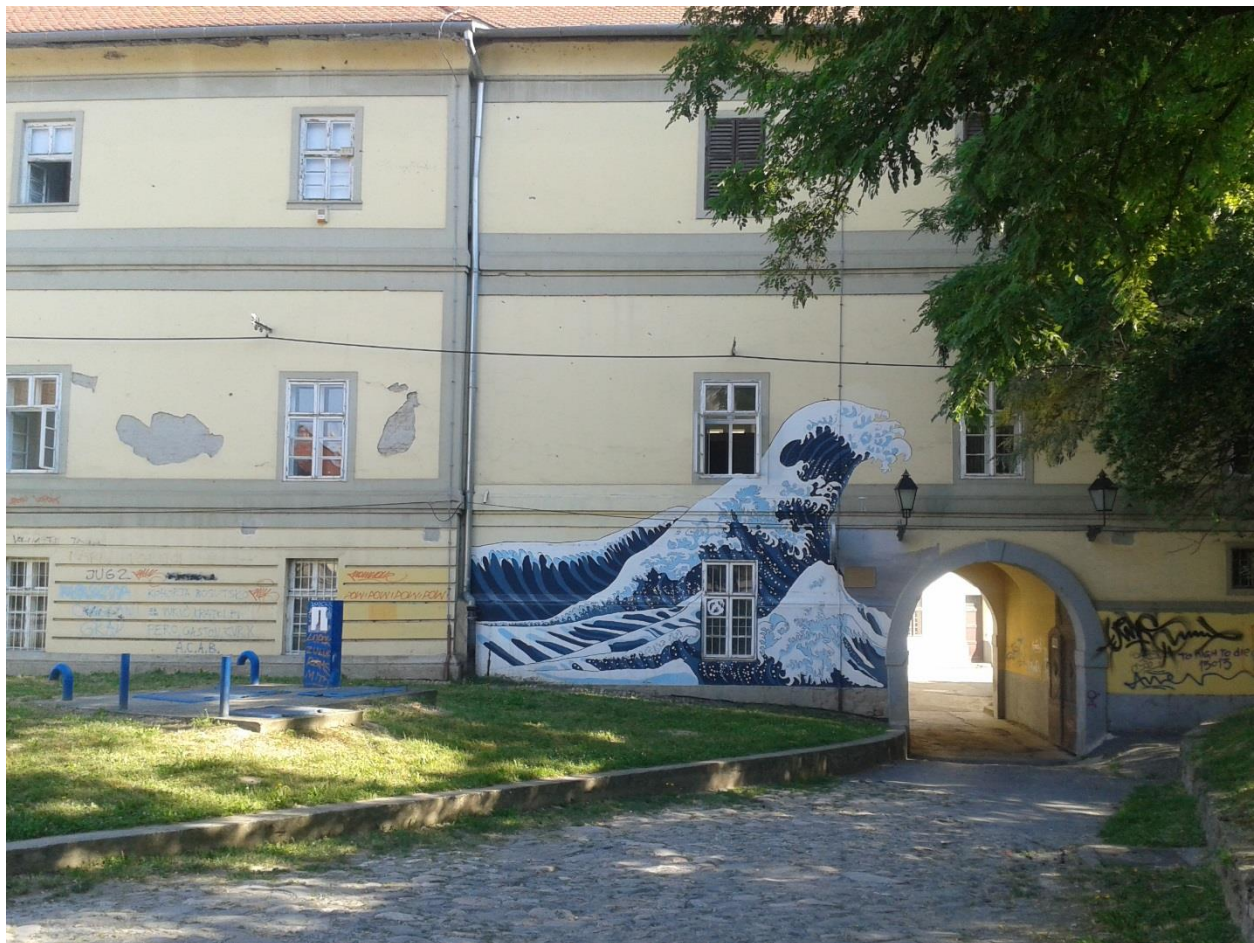
Fotografija 1. Ulaz u dvorište škole/ zgrada škole
