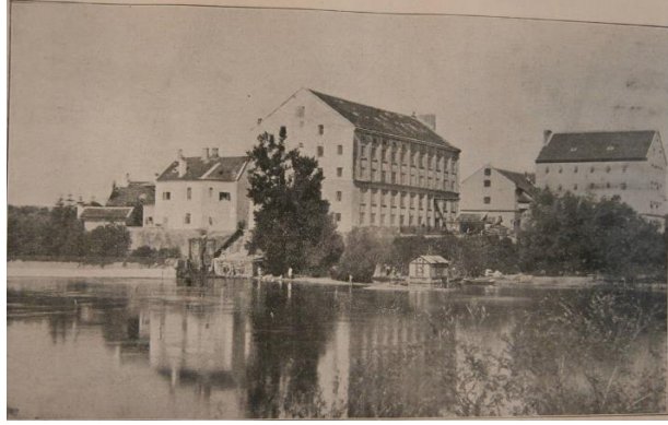
Slika 21. Prvi hrvatski mlin na čigre (turbine) u Karlovcu (Liljan, 1897, 10, 157)
