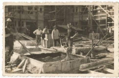
Prilog 2. Početak izgradnje zgrada na Drvljaniku, 1965. godina
