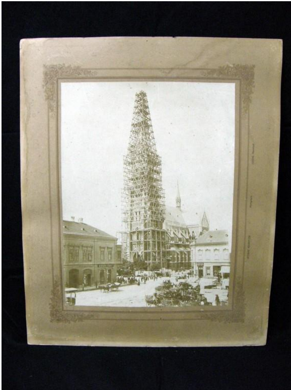
Slika 7: Fotografija izgradnje osječke katedrale
