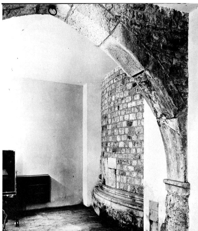
Prilog 52: Ostaci „Kibelinog“ hrama u zgradi zapadno od Peristila
