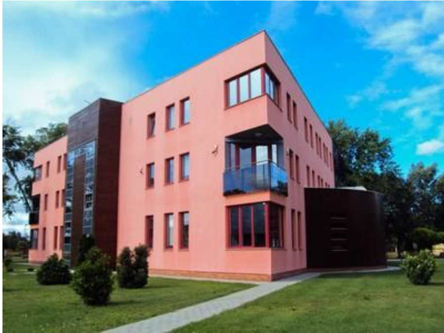
Slika 5. Zgrada Gradske knjižnice i čitaonice Belišće
