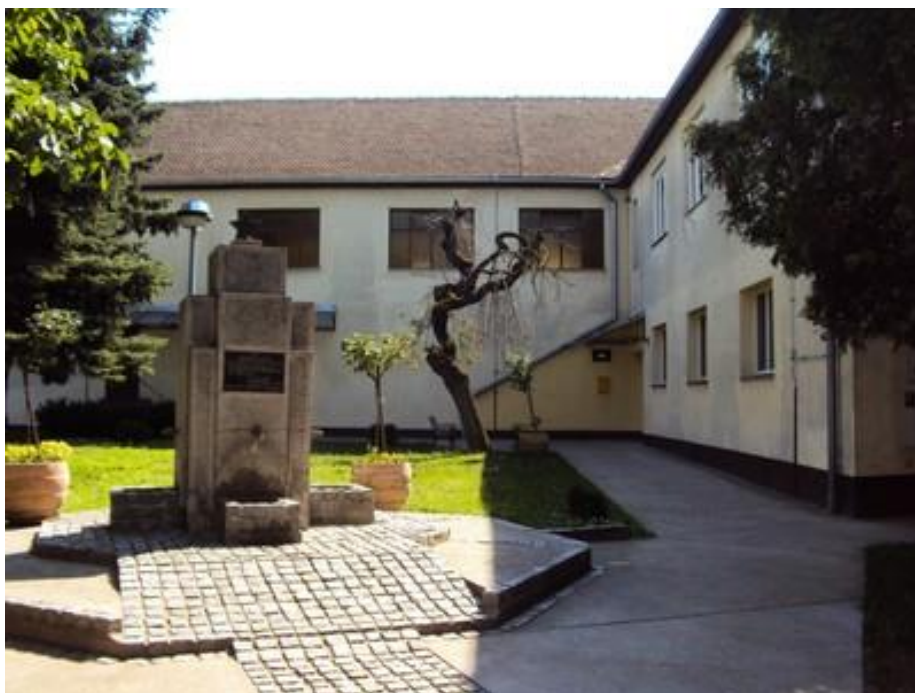
Slika 13. Zgrada Narodne knjižnice Dalj
