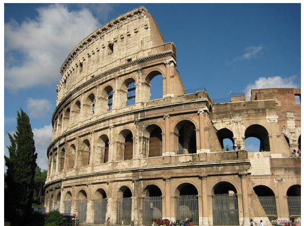
Slika 3: Kolosej izvana, sa lukovima i tri tipa stupova te pilastarom na vrhu
