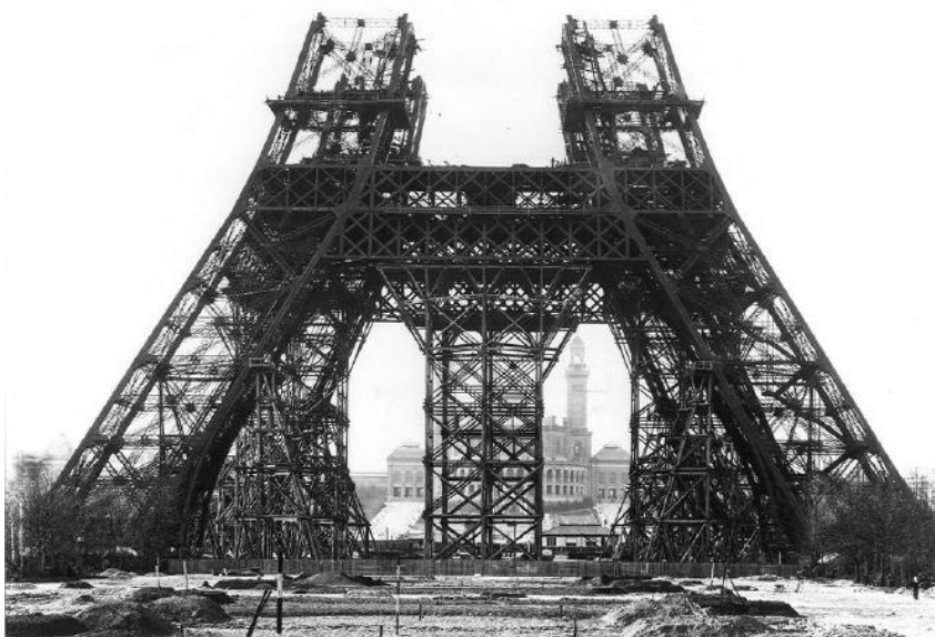
Prilog 2. Eiffelov toranj u fazi izgradnje; prva polovica 1888. godine
