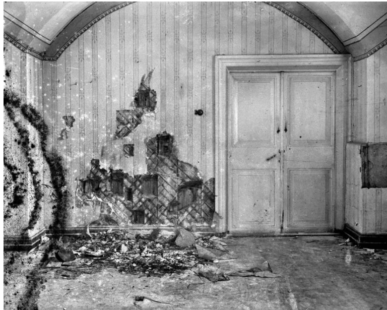
Prilog 3. Podrum Kuće posebne namjene, mjesto na kojemu je smaknuta obitelj Romanov, Jekaterinburg
