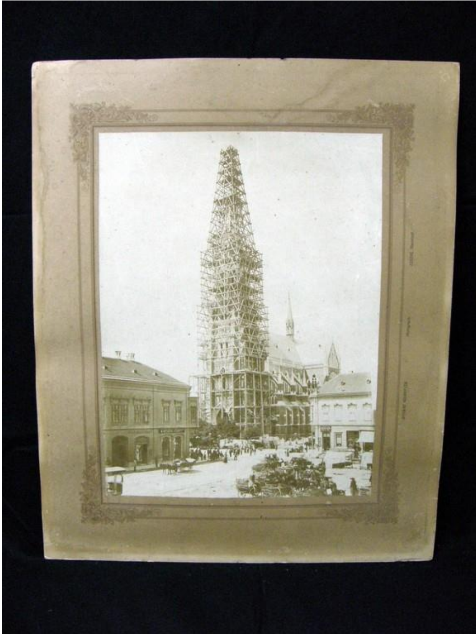
Slika 7: Fotografija izgradnje osječke katedrale
