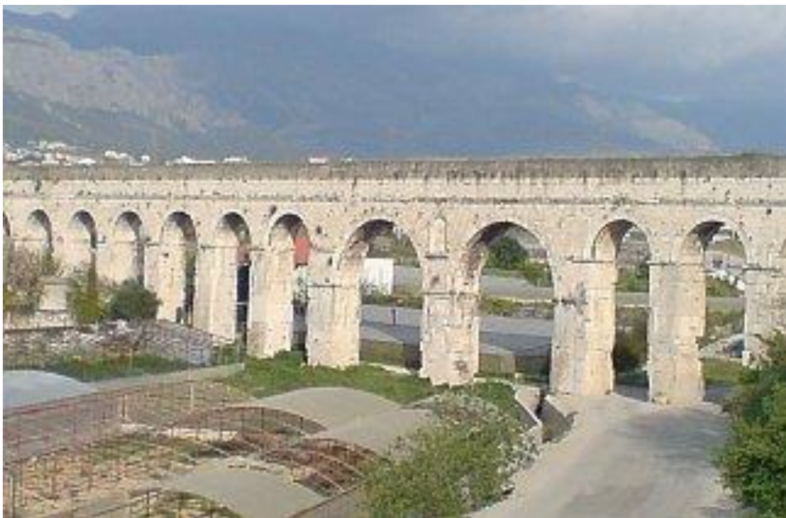
Prilog 40: Rimski akvadukt za opskrbu Dioklecijanove palače vodom
