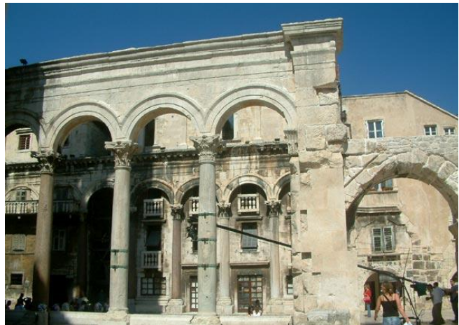
Prilog 43: Stupovi Peristila
